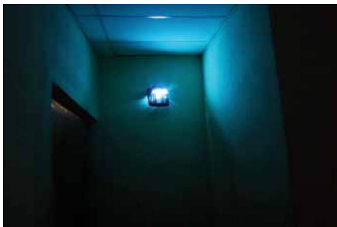
Figura 12. Cuarto oscuro de entrada para invernaderos con trampa de luz uv para insectos
