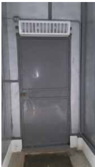
Figura 38. Invernadero nivel 1 del Proyecto HLB-OIR-SA-ICDF, con cortina de aire para evitar la entrada de insectos y pediluvio.
